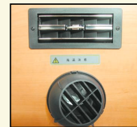
上:クーラー吹き出し口 下:ヒーター吹き出し口
