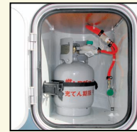
プロパンGASボンベ。スペースは、縦列に2個。標準は1個。
