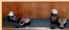
2つの蛇口。シンク下のポリタンクからの清水用と、大型タンクの生活用水（87L）用とに分けてあります。
